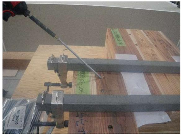
写真 3.2-2 施工の様子 ビス打ち
