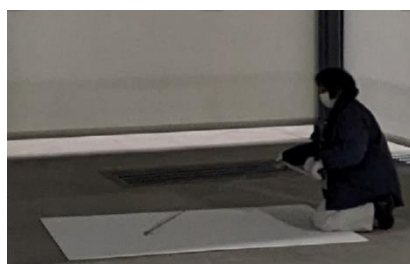
写真 6.2 ケイカル板の設置
